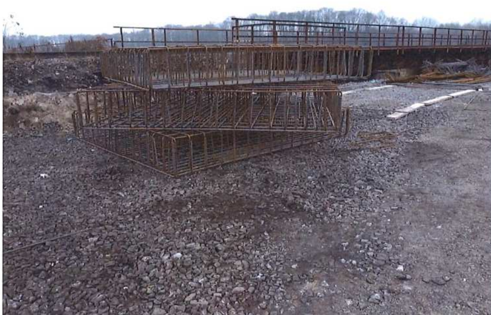
Dovoz armatúry pre základy výsuvnej dráhy – pre výsuv oc.konštrukcie SO 12-33-04
