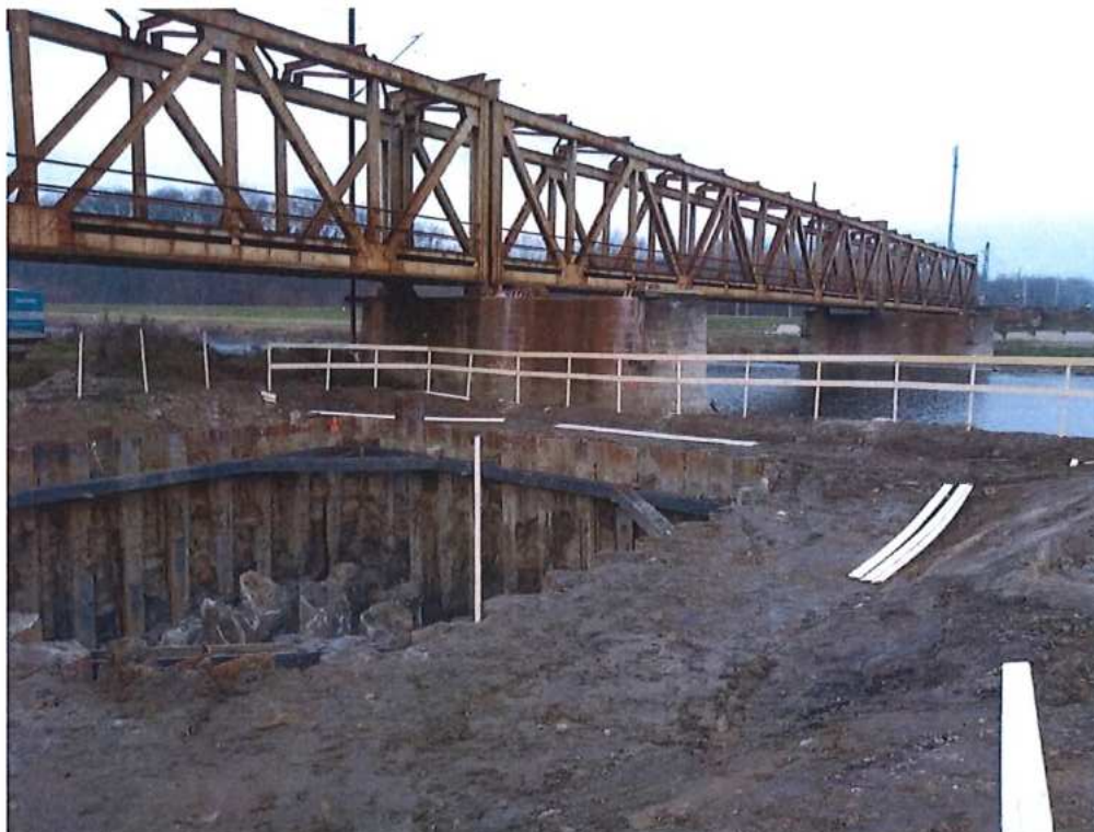
Výkop základu pre pilier P1 na strane SK
