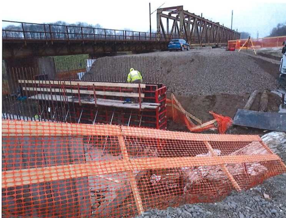
Zabetónovanie bočnej steny priepustu SO 12-33-03
